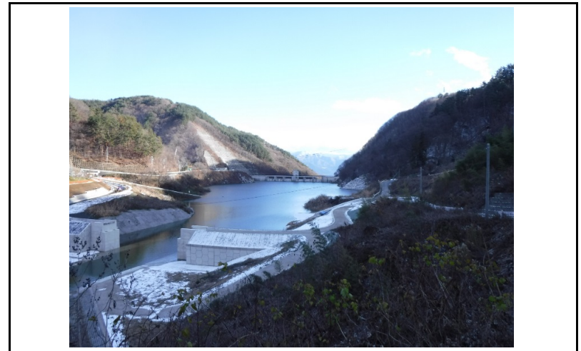
4 貯水池(上流からの全景)
