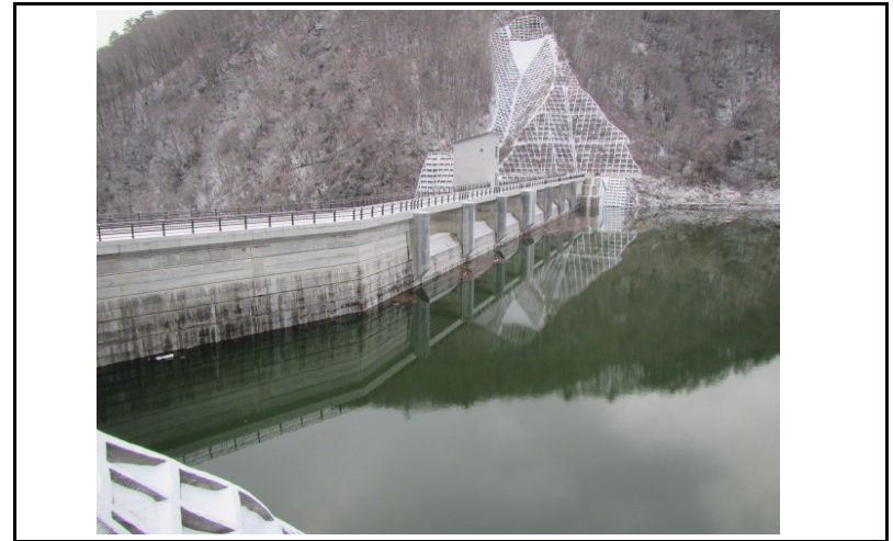
2 ダム上流面(左岸から)
