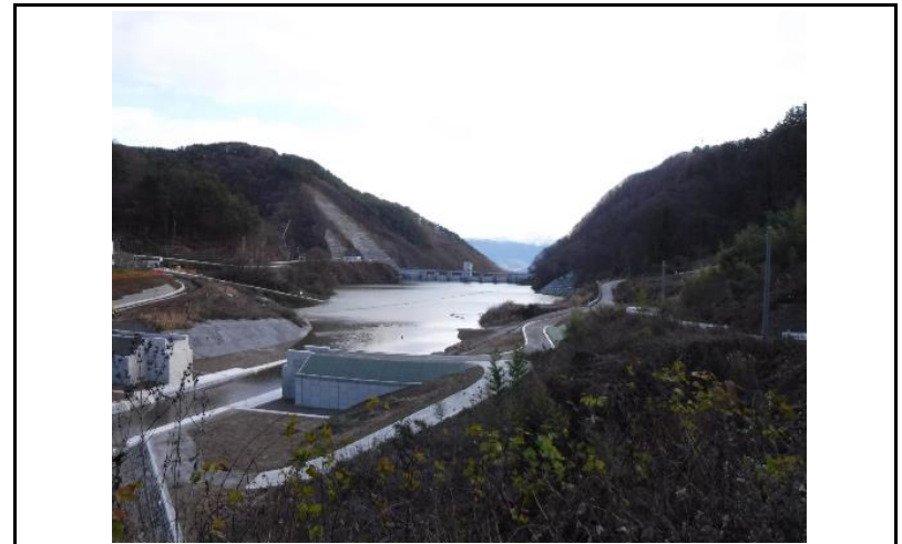
4 貯水池(上流からの全景)
