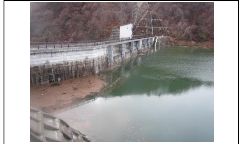
2 ダム上流面(左岸から)
