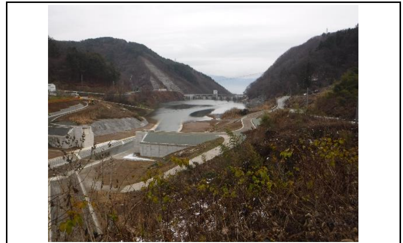
4 貯水池(上流からの全景)
