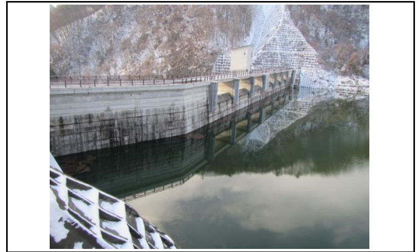
2 ダム上流面(左岸から)
