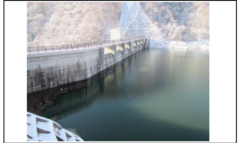
2 ダム上流面(左岸から)
