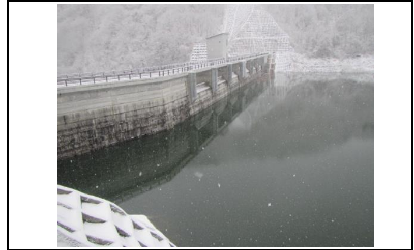
2 ダム上流面(左岸から)
