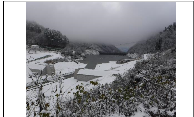
4 貯水池(上流からの全景)
