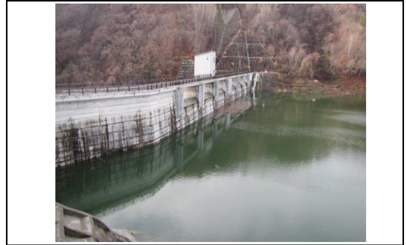
2 ダム上流面(左岸から)
