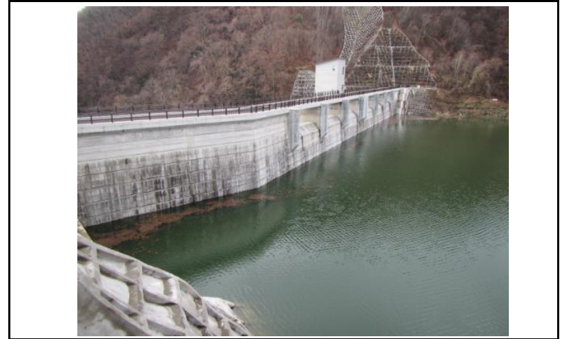
2 ダム上流面(左岸から)
