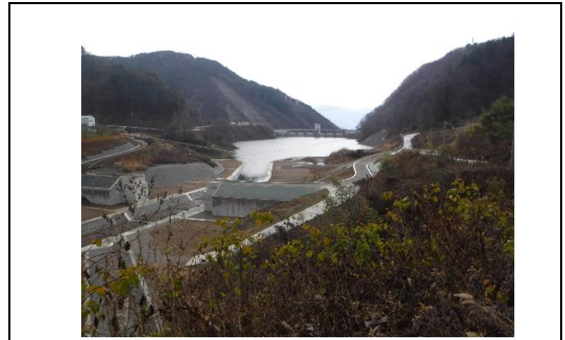
4 貯水池(上流からの全景)
