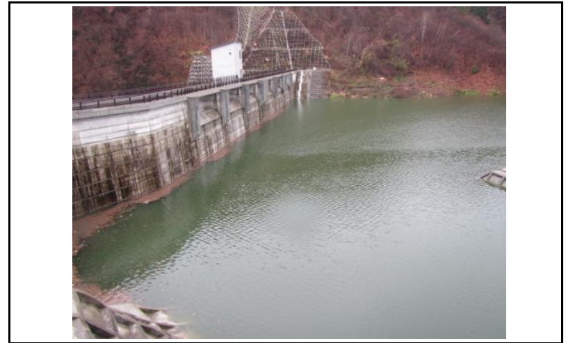
2 ダム上流面(左岸から)
