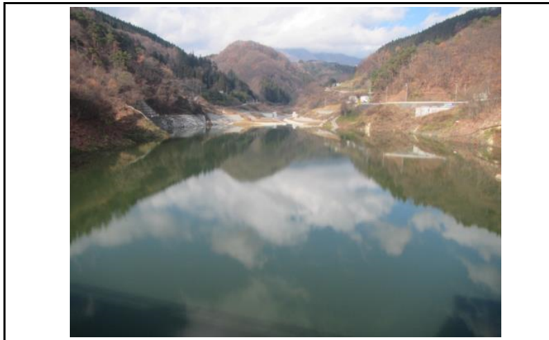
3 貯水池(ダムから上流)
