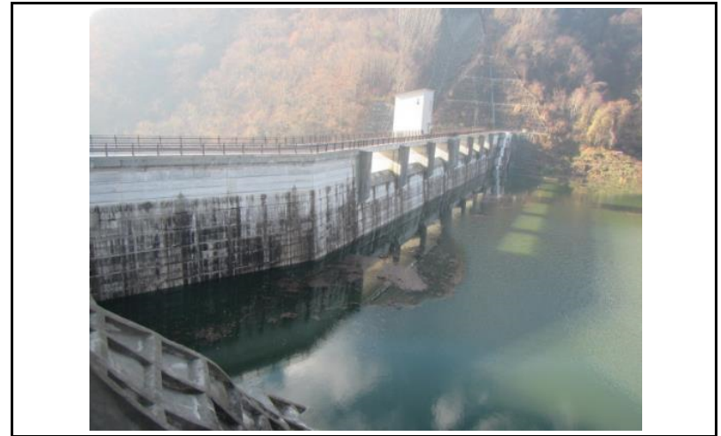
2 ダム上流面(左岸から)
