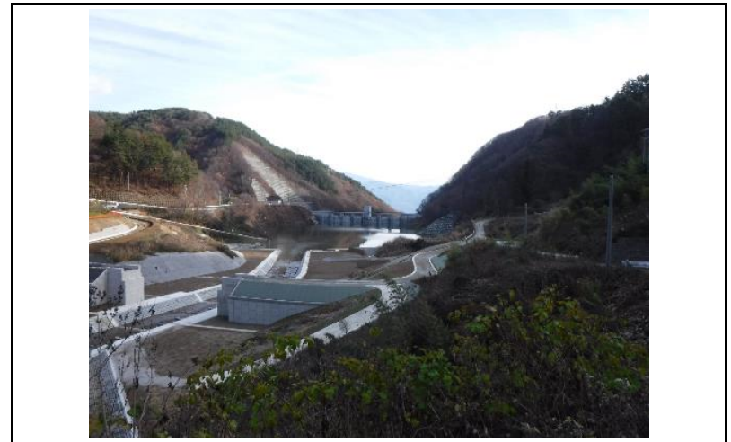
4 貯水池(上流からの全景)
