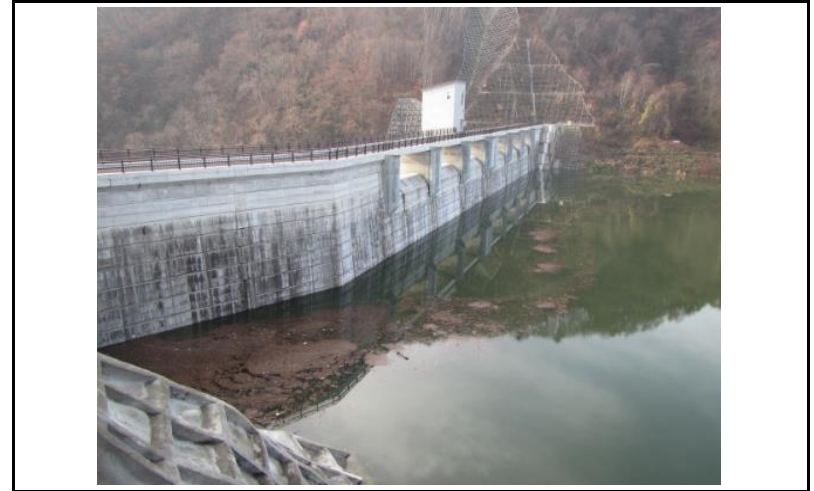
2 ダム上流面(左岸から)
