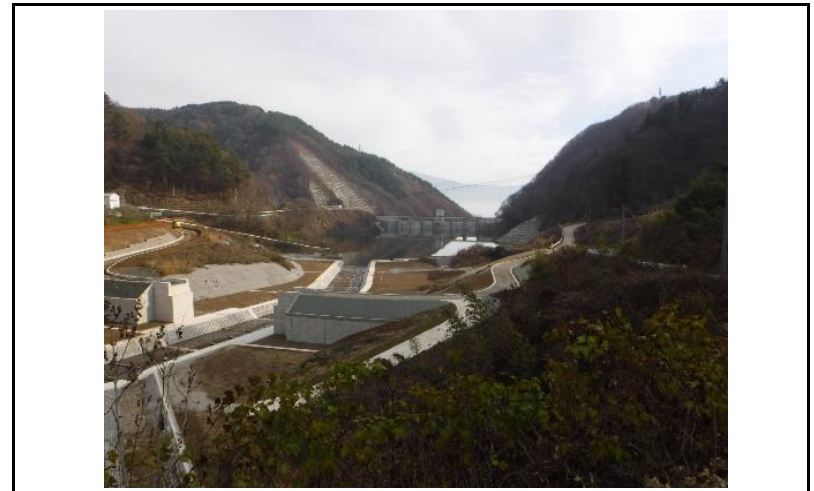
4 貯水池(上流からの全景)
