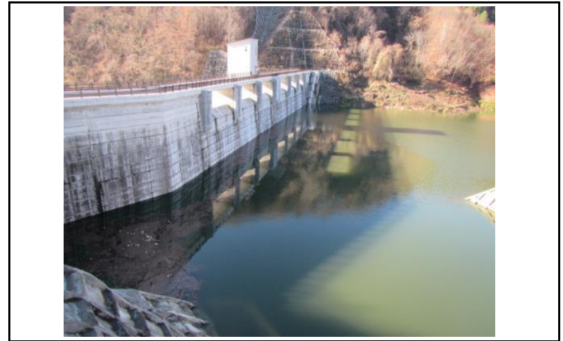
2 ダム上流面(左岸から)
