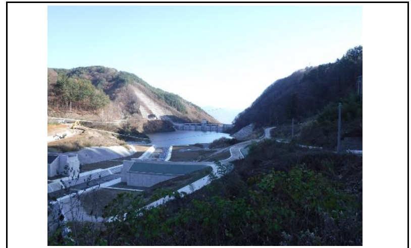
4 貯水池(上流からの全景)
