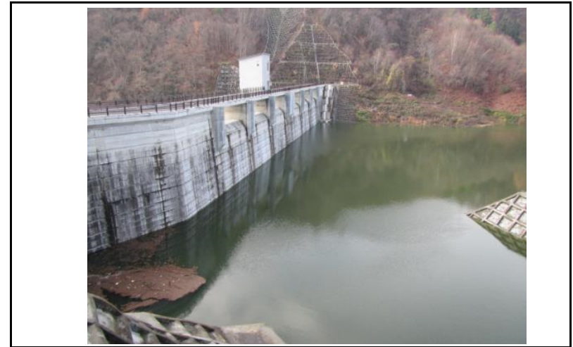
2 ダム上流面(左岸から)
