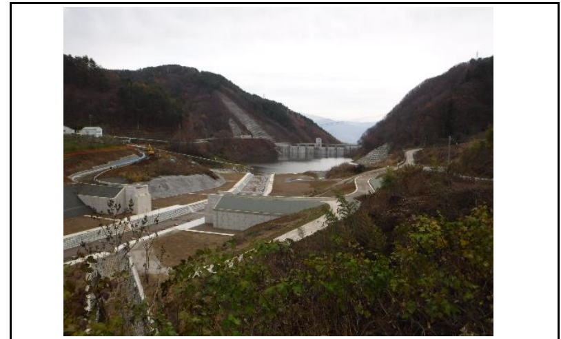
4 貯水池(上流からの全景)
