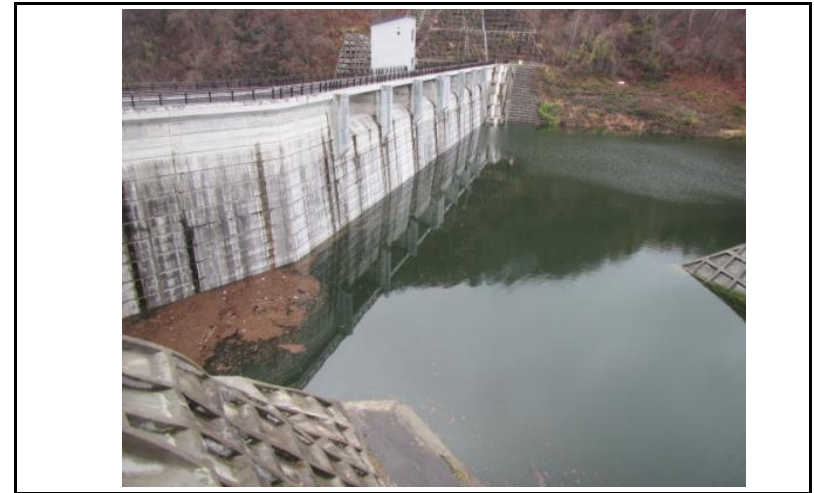
2 ダム上流面(左岸から)
