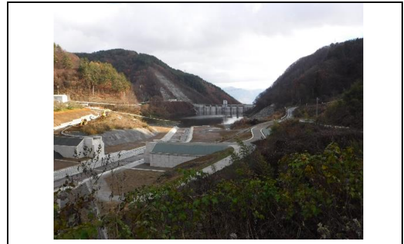
4 貯水池(上流からの全景)
