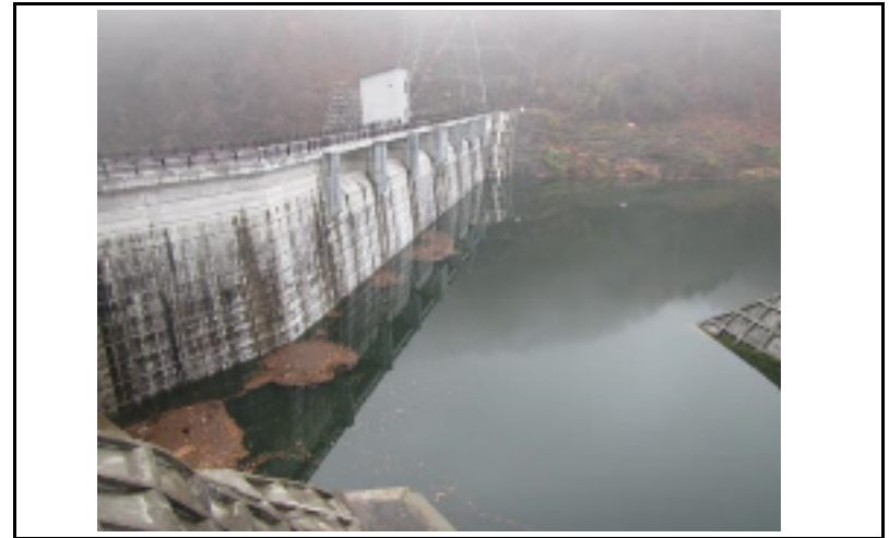
2 ダム上流面(左岸から)
