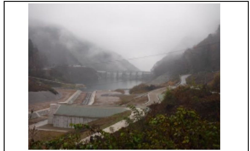
4 貯水池(上流からの全景)
