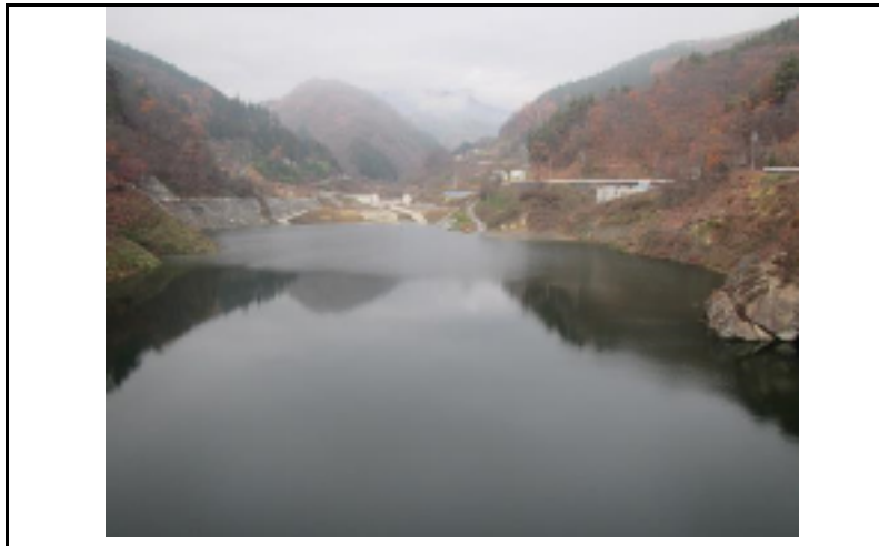
3 貯水池(ダムから上流)
