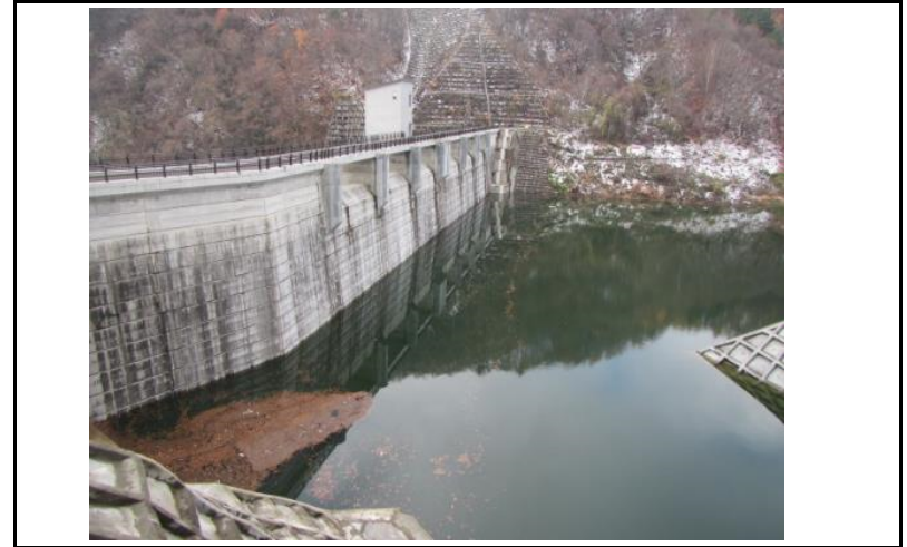
2 ダム上流面(左岸から)
