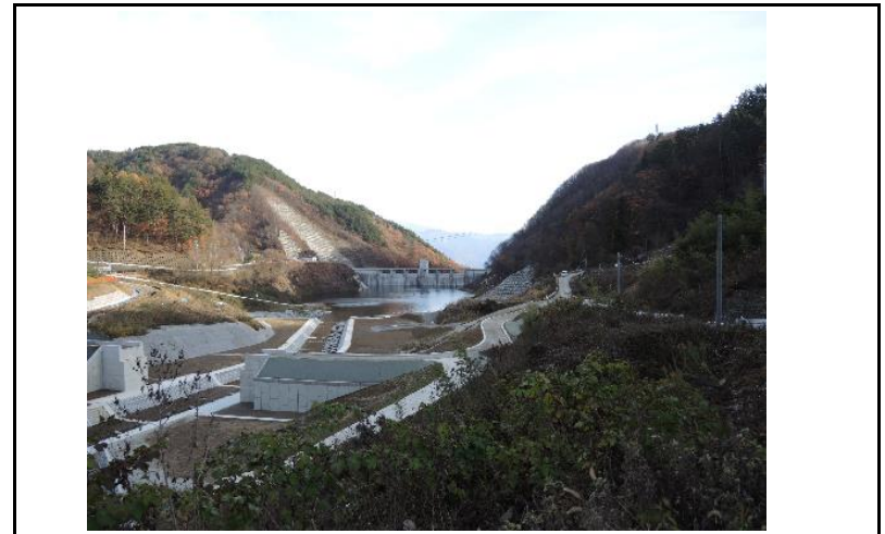
4 貯水池(上流からの全景)
