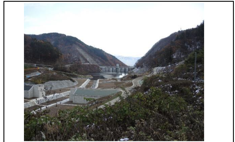
4 貯水池(上流からの全景)
