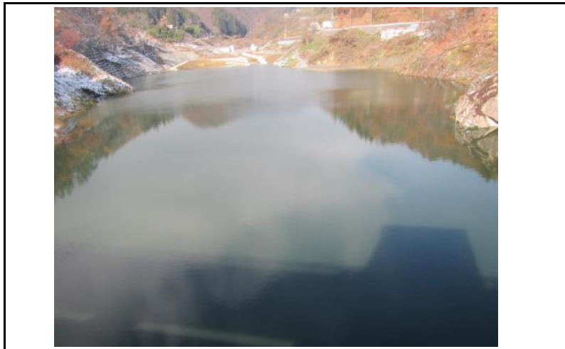
3 貯水池(ダムから上流)
