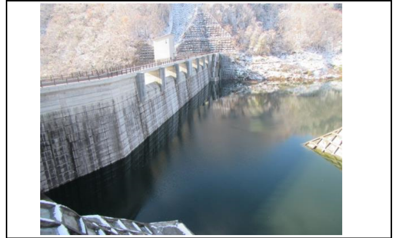
2 ダム上流面(左岸から)
