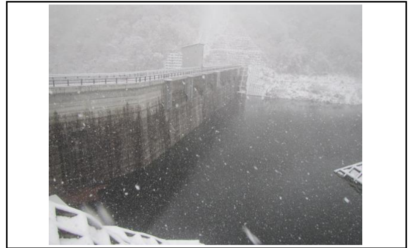
2 ダム上流面(左岸から)
