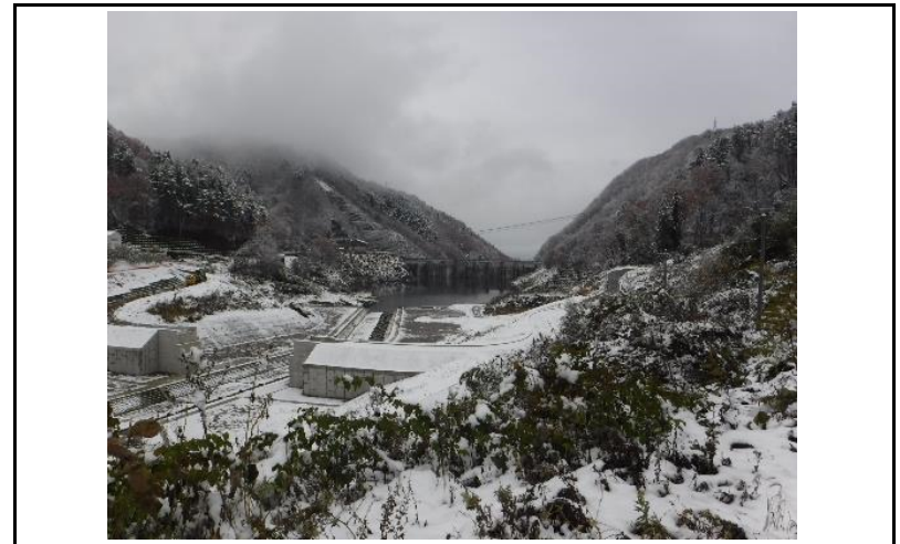
4 貯水池(上流からの全景)
