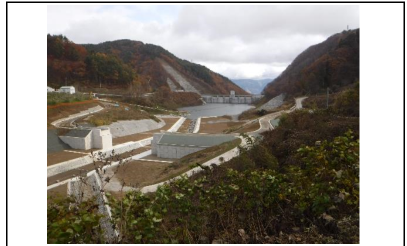
4 貯水池(上流からの全景)
