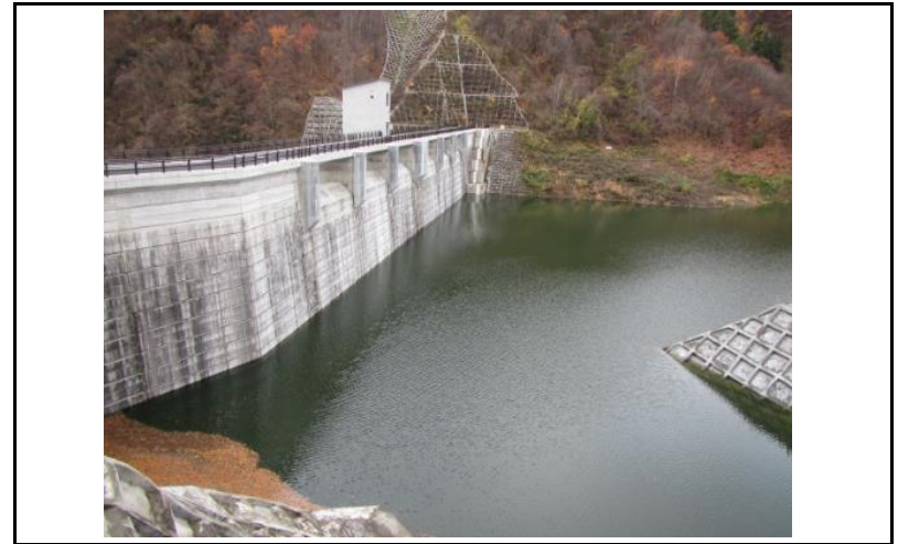
2 ダム上流面(左岸から)
