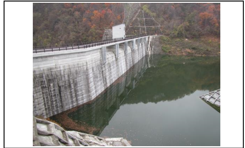
2 ダム上流面(左岸から)
