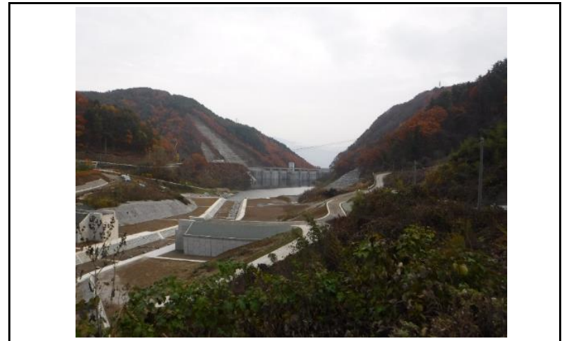
4 貯水池(上流からの全景)
