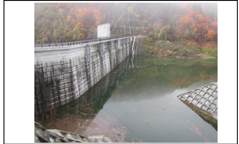
2 ダム上流面(左岸から)
