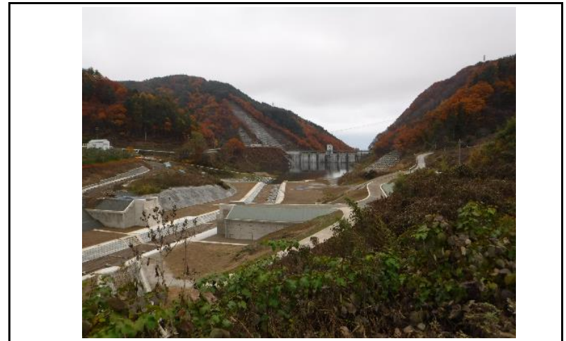
4 貯水池(上流からの全景)
