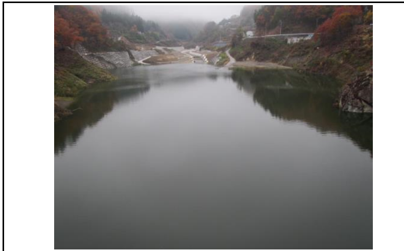
3 貯水池(ダムから上流)
