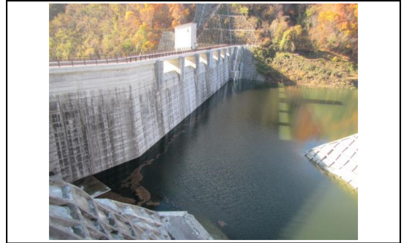
2 ダム上流面(左岸から)
