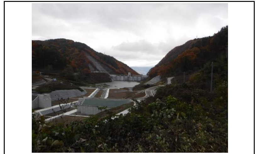
4 貯水池(上流からの全景)
