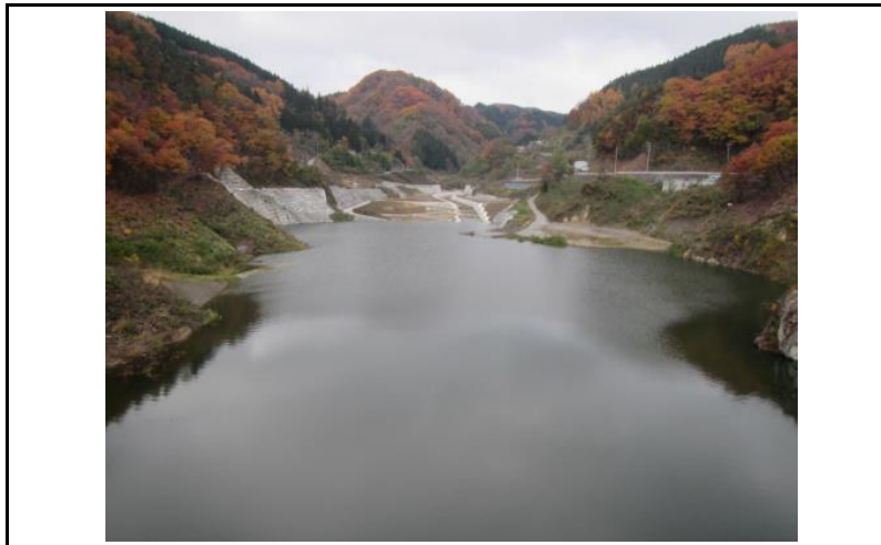
3 貯水池(ダムから上流)
