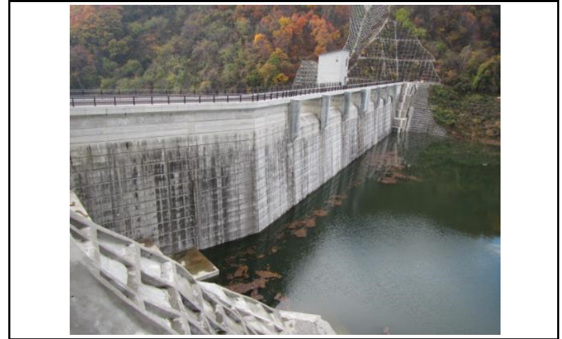
2 ダム上流面(左岸から)
