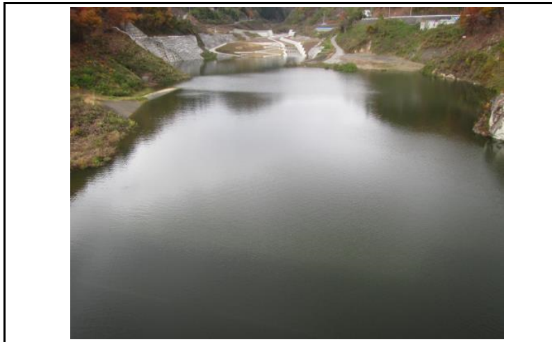
3 貯水池(ダムから上流)
