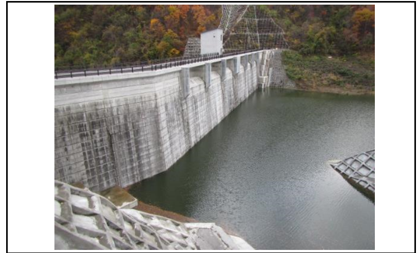
2 ダム上流面(左岸から)
