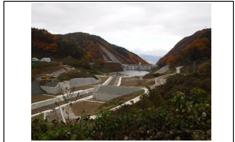
4 貯水池(上流からの全景)
