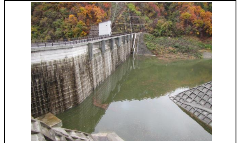
2 ダム上流面(左岸から)
