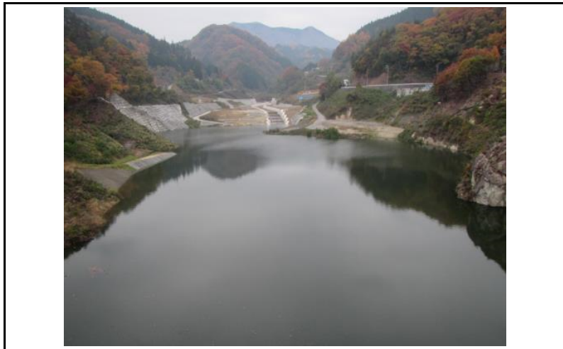
3 貯水池(ダムから上流)
