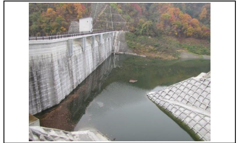
2 ダム上流面(左岸から)
