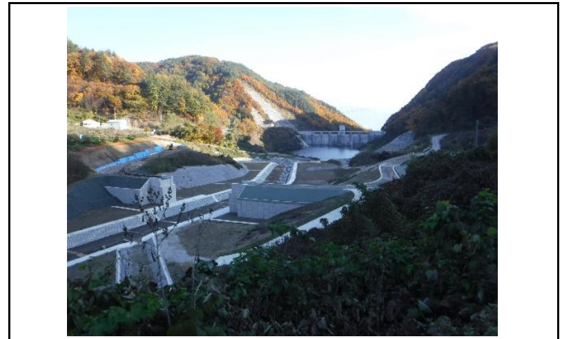
4 貯水池(上流からの全景)
