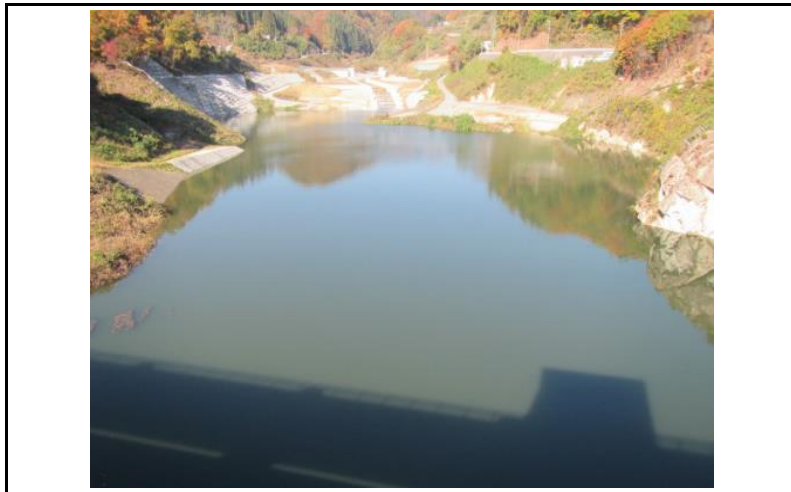
3 貯水池(ダムから上流)
