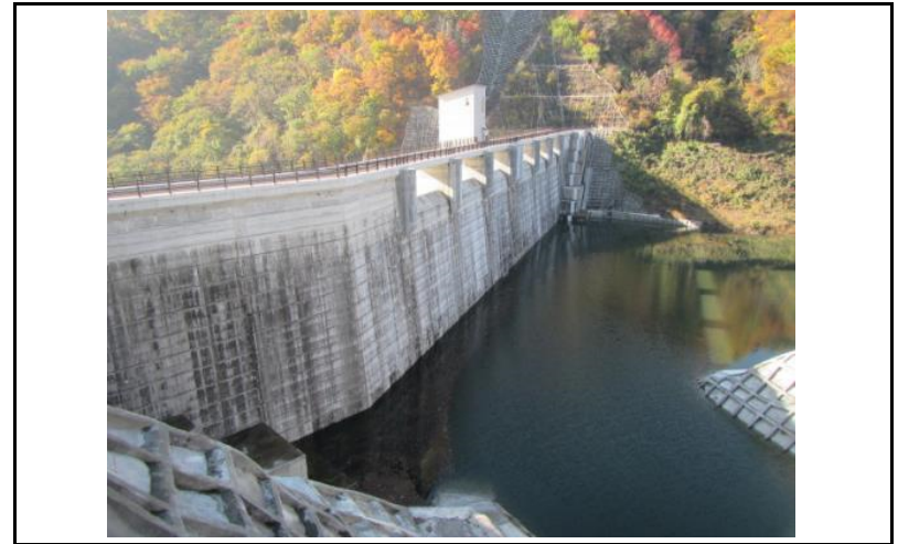
2 ダム上流面(左岸から)
