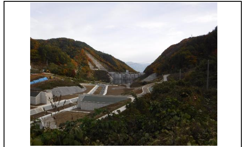
4 貯水池(上流からの全景)
