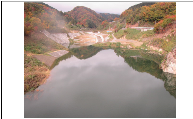
3 貯水池(ダムから上流)
