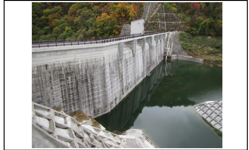
2 ダム上流面(左岸から)
