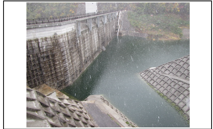
2 ダム上流面(左岸から)
