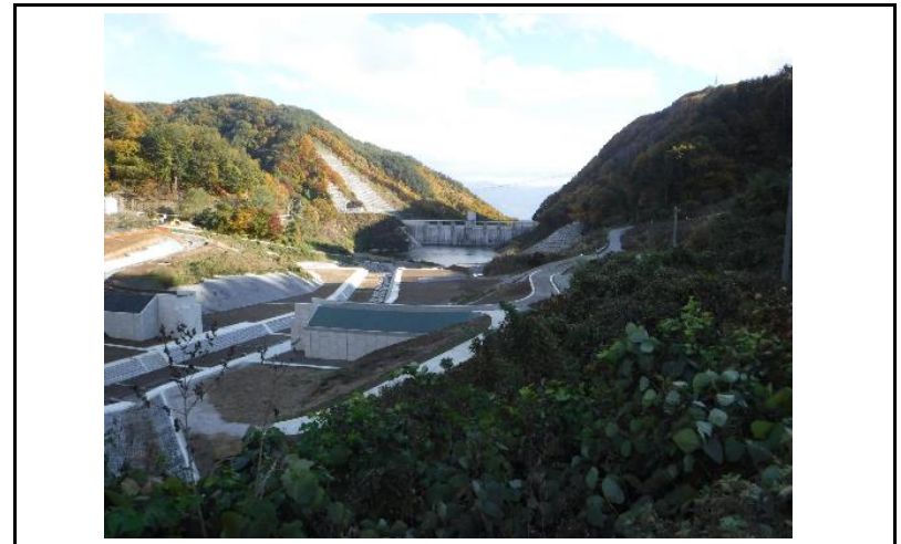
4 貯水池(上流からの全景)
