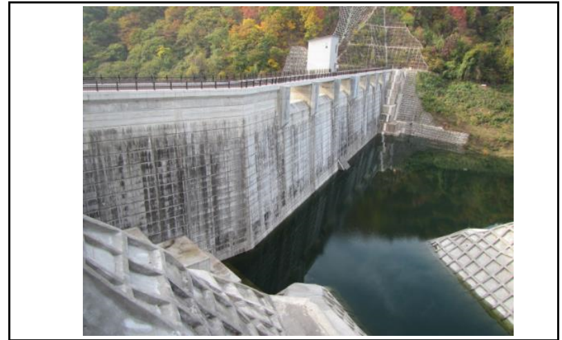
2 ダム上流面(左岸から)
