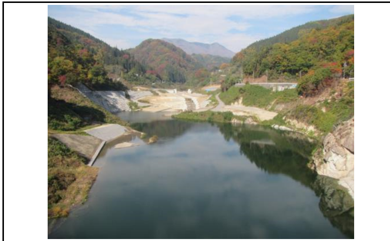
3 貯水池(ダムから上流)
