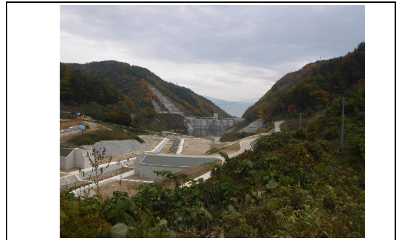
4 貯水池(上流からの全景)
