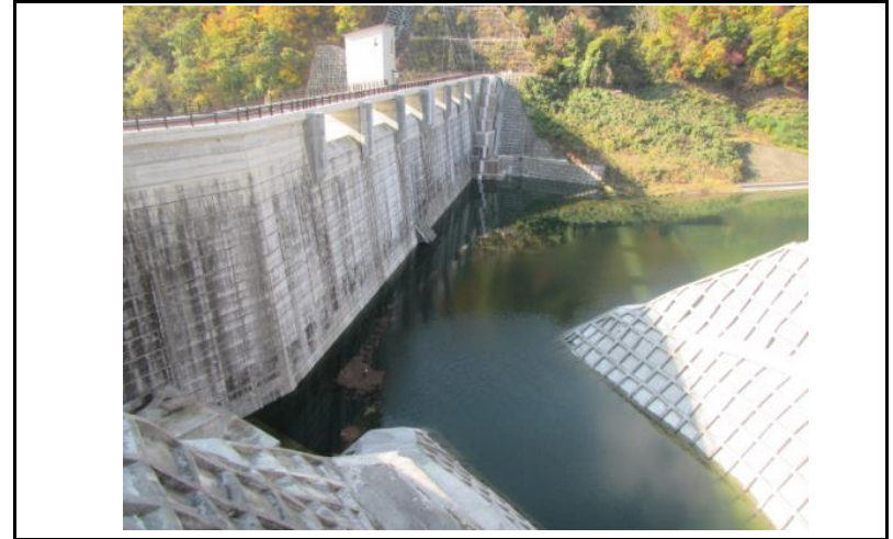
2 ダム上流面(左岸から)
