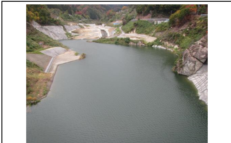
3 貯水池(ダムから上流)
