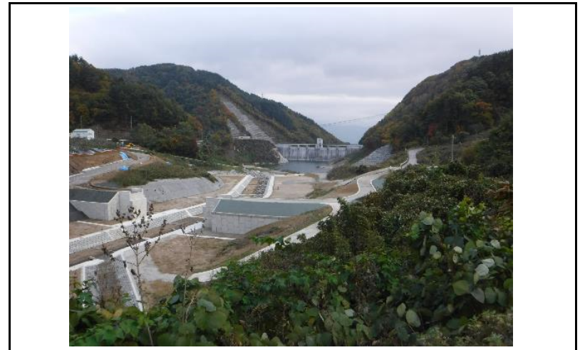
4 貯水池(上流からの全景)
