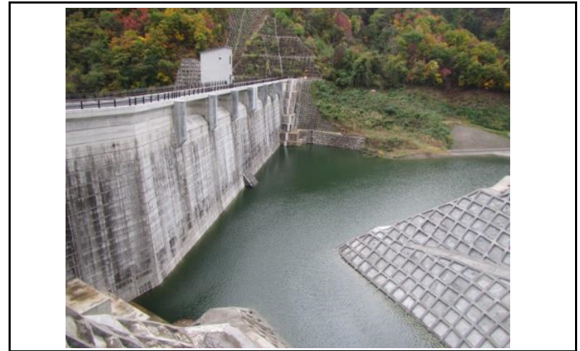
2 ダム上流面(左岸から)
