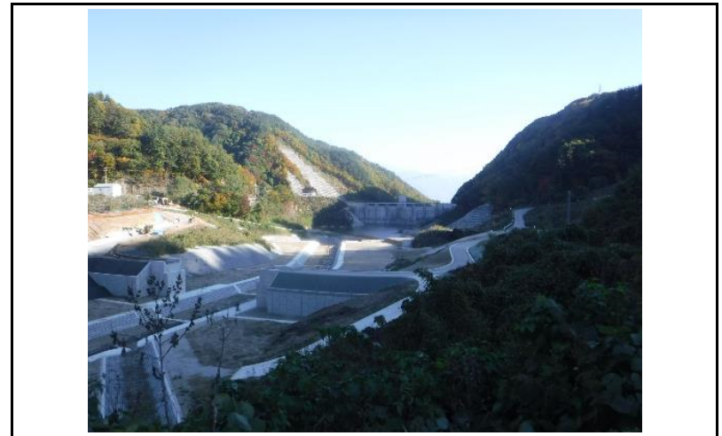
4 貯水池(上流からの全景)
