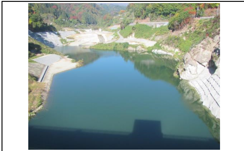
3 貯水池(ダムから上流)
