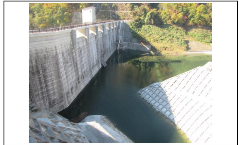
2 ダム上流面(左岸から)
