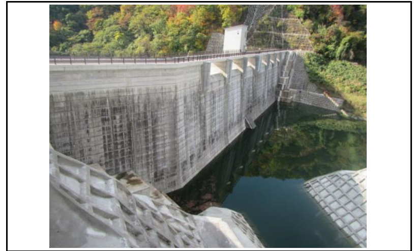
2 ダム上流面(左岸から)
