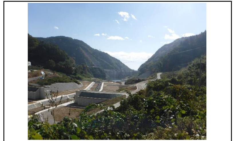
4 貯水池(上流からの全景)
