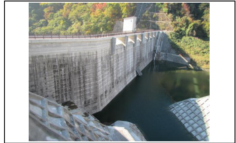
2 ダム上流面(左岸から)
