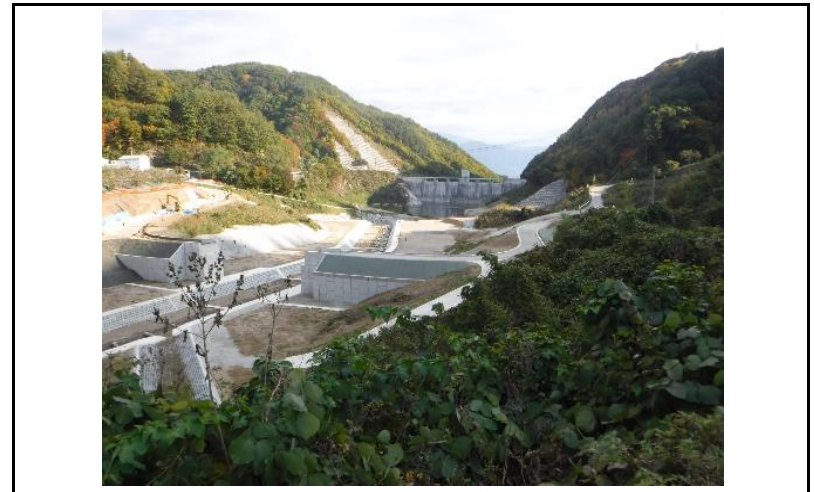
4 貯水池(上流からの全景)
