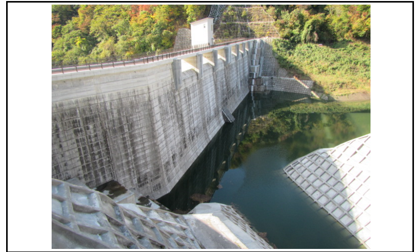
2 ダム上流面(左岸から)
