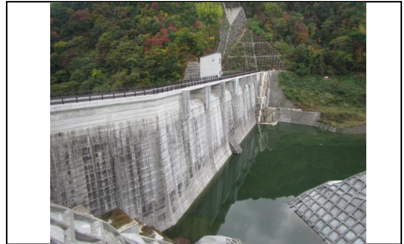
2 ダム上流面(左岸から)
