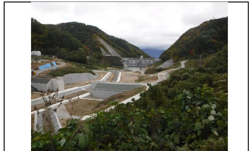
4 貯水池(上流からの全景)
