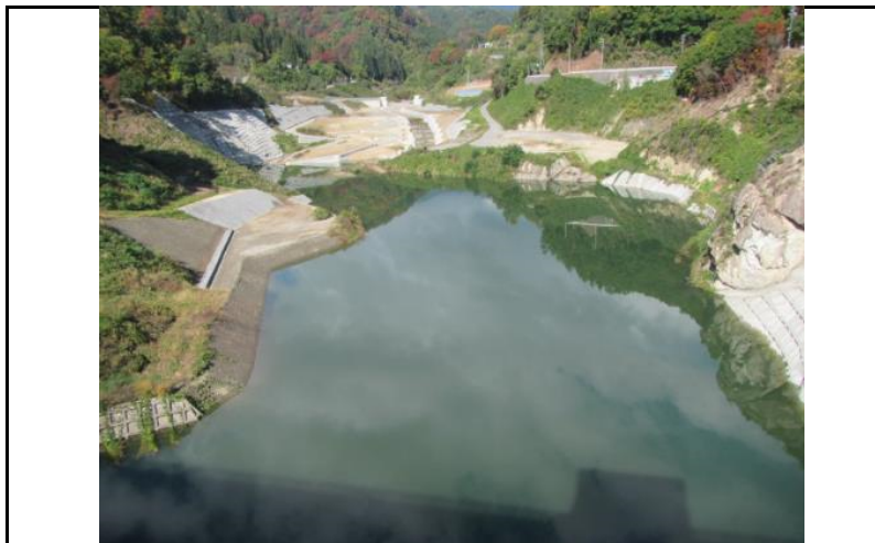
3 貯水池(ダムから上流)
