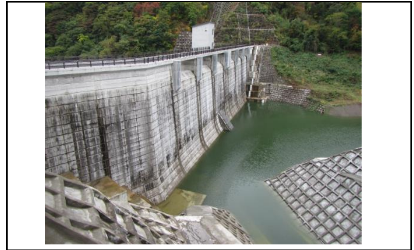
2 ダム上流面(左岸から)
