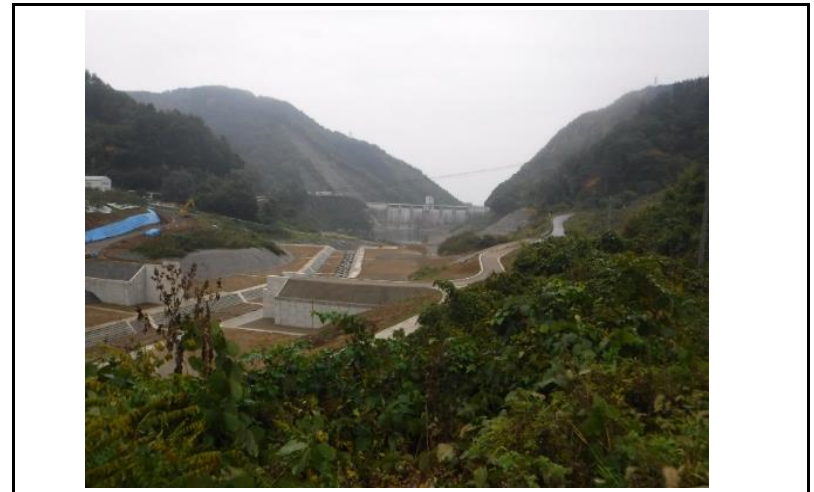
4 貯水池(上流からの全景)
