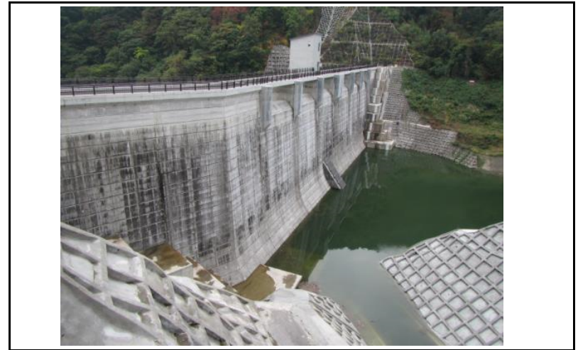
2 ダム上流面(左岸から)
