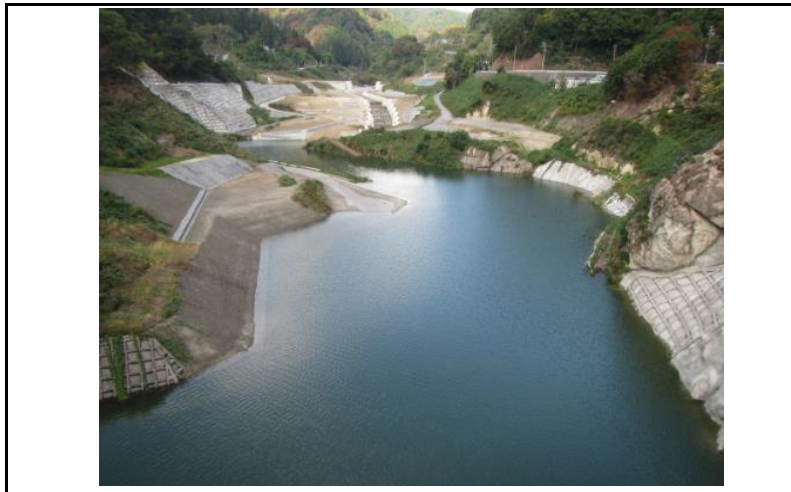
3 貯水池(ダムから上流)
