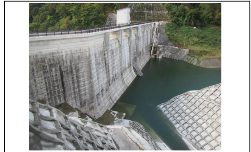
2 ダム上流面(左岸から)
