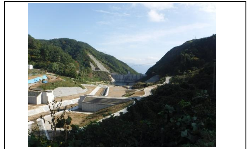
4 貯水池(上流からの全景)
