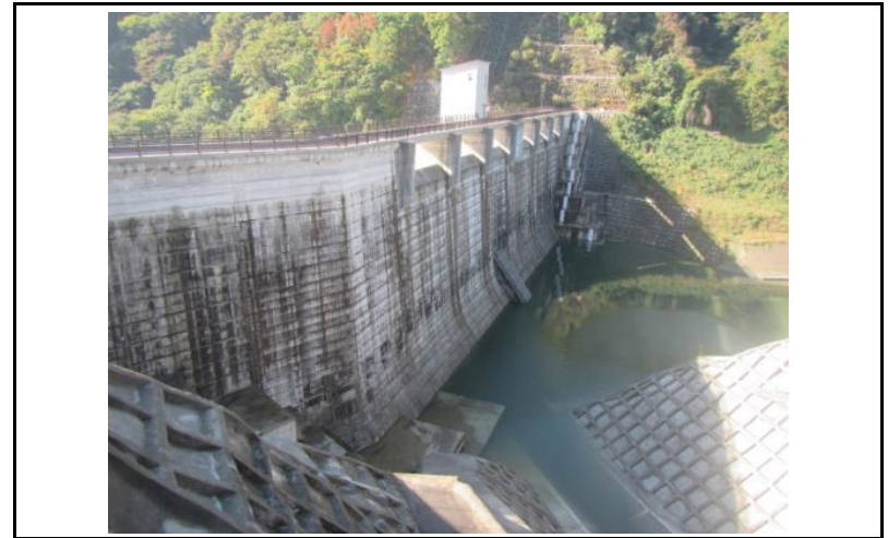
2 ダム上流面(左岸から)
