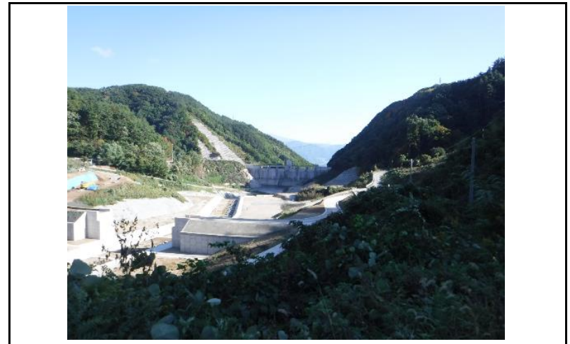
4 貯水池(上流からの全景)
