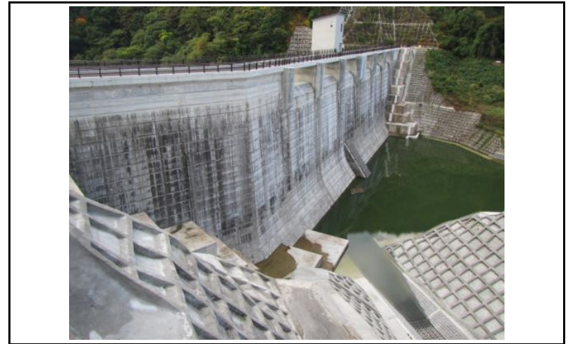
2 ダム上流面(左岸から)
