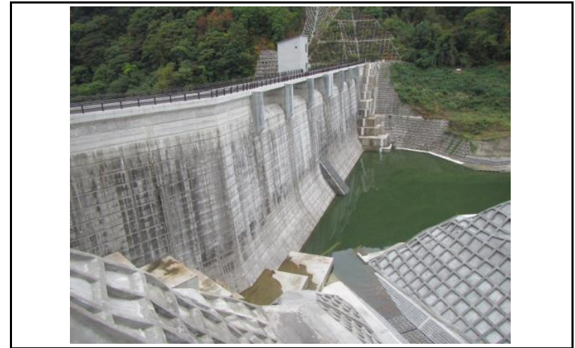
2 ダム上流面(左岸から)
