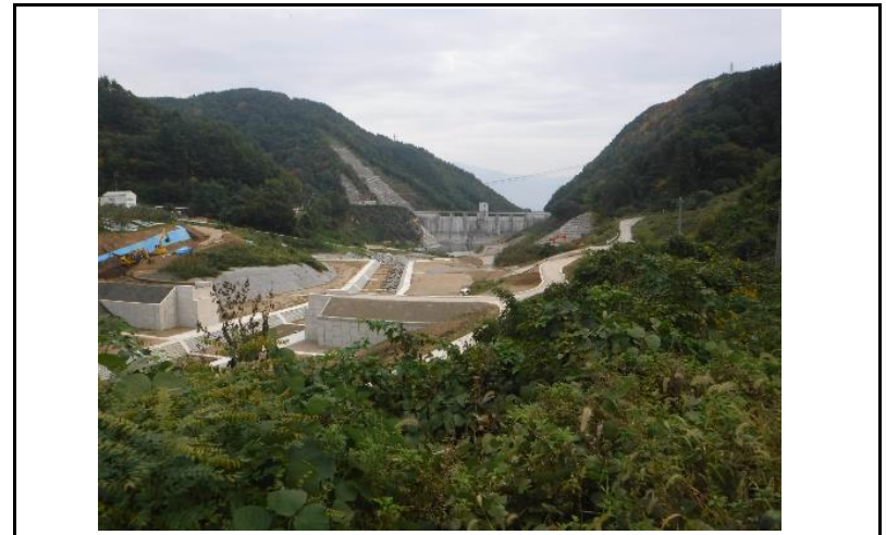
4 貯水池(上流からの全景)
