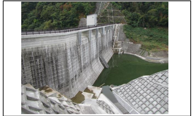
2 ダム上流面(左岸から)
