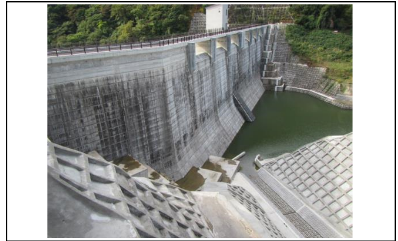
2 ダム上流面(左岸から)
