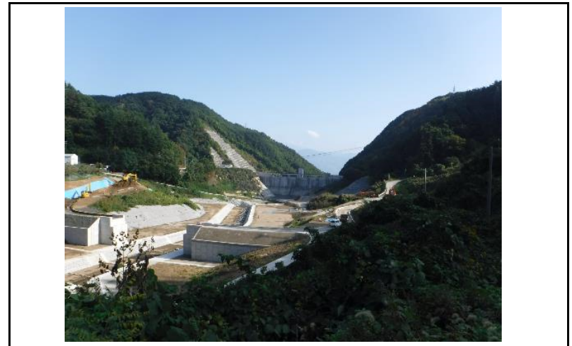
4 貯水池(上流からの全景)
