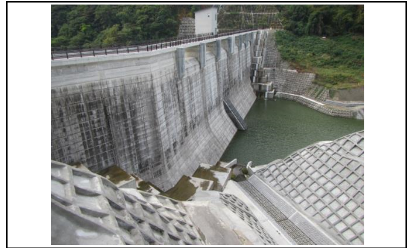
2 ダム上流面(左岸から)
