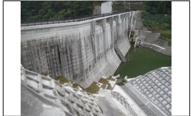
2 ダム上流面(左岸から)
