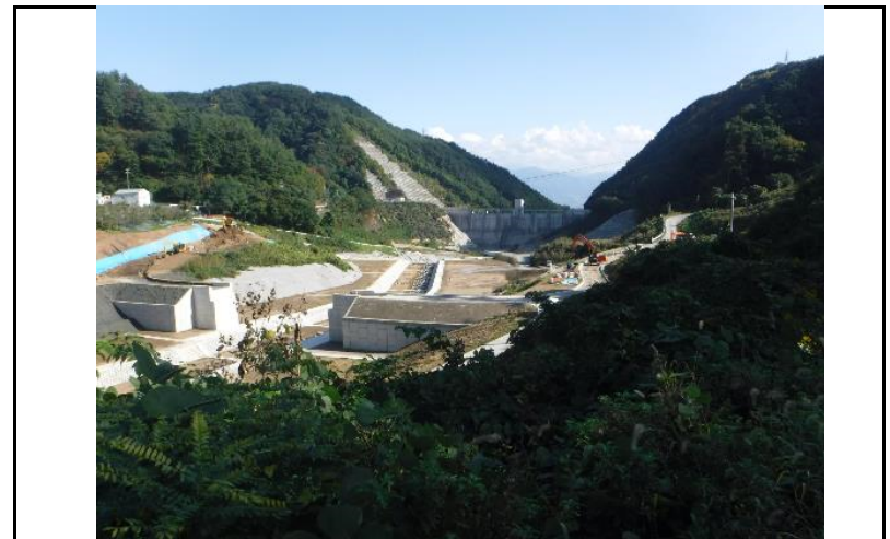
4 貯水池(上流からの全景)
