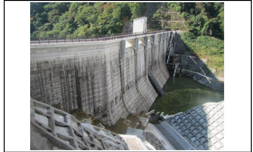
2 ダム上流面(左岸から)
