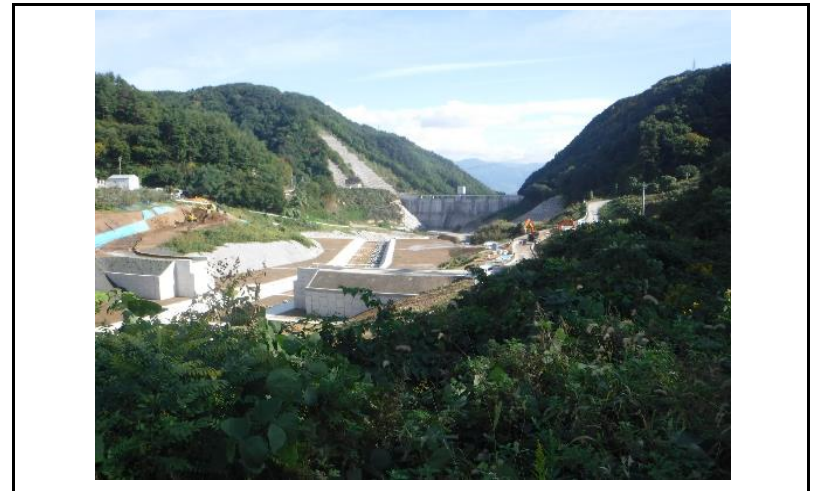
4 貯水池(上流からの全景)
