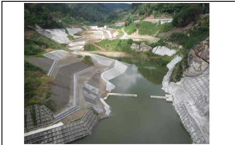
3 貯水池(ダムから上流)
