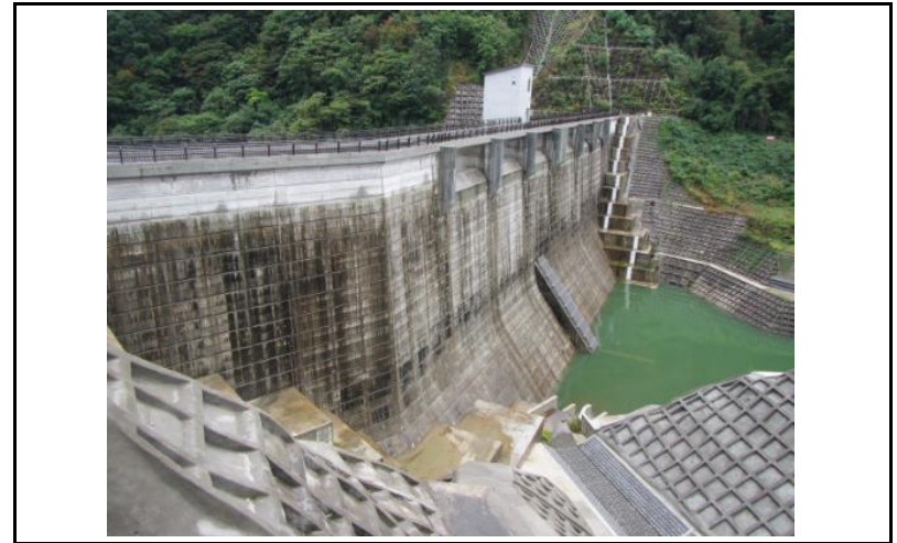
2 ダム上流面(左岸から)
