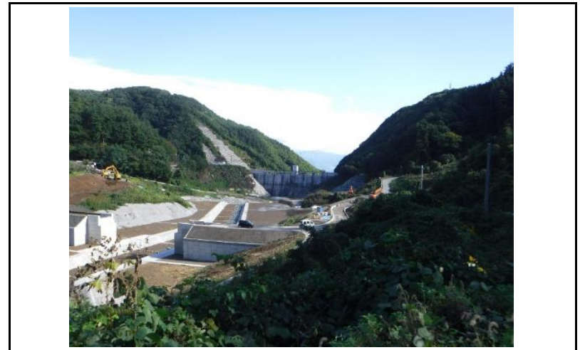
4 貯水池(上流からの全景)
