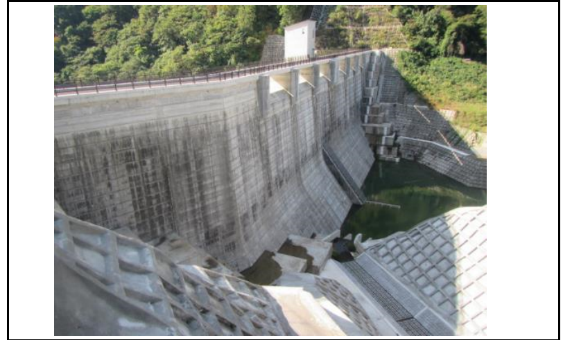
2 ダム上流面(左岸から)
