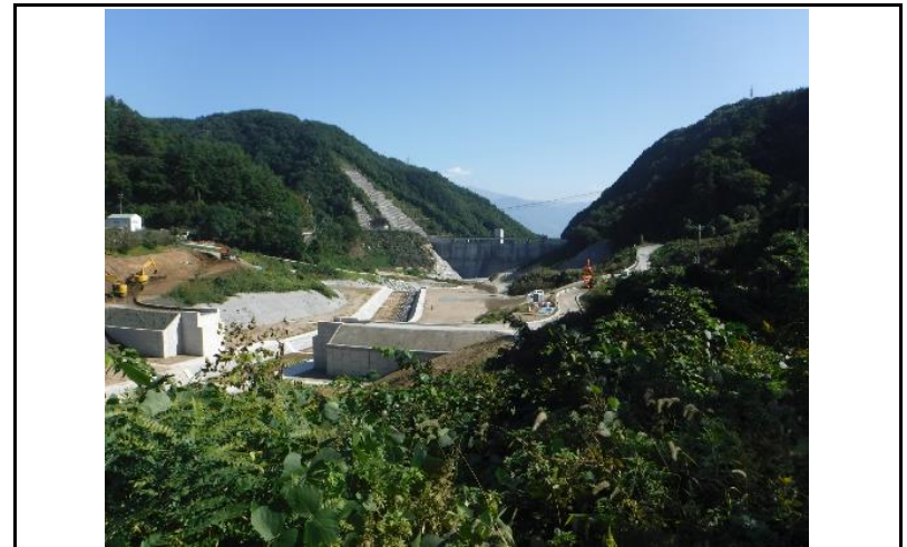
4 貯水池(上流からの全景)
