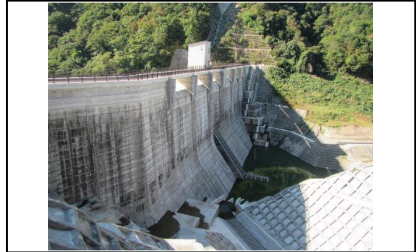
2 ダム上流面(左岸から)
